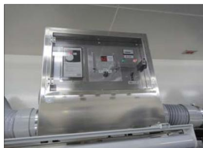
給気装置(給気ボリューム三段切替スイッチ搭載)
